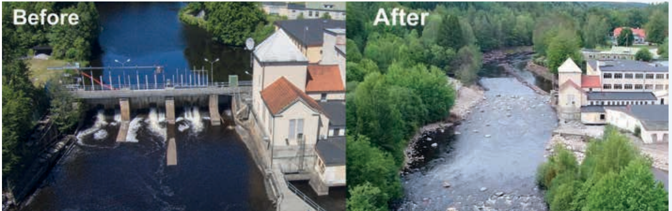
Ejemplo de restauración fluvial dentro del proyecto LIFE CONNECTS que muestra la eliminación de la central hidroeléctrica de Marieberg en Mörrumsån. © Uniper
