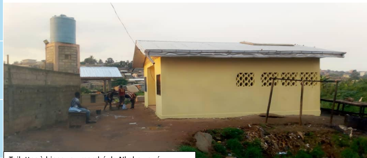
Toilettes à biogaz au marché de Nkolondom
